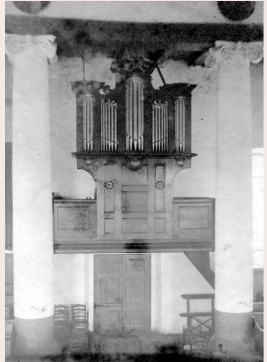
Het in 1866 geplaatste orgel boven de hoofdingang
